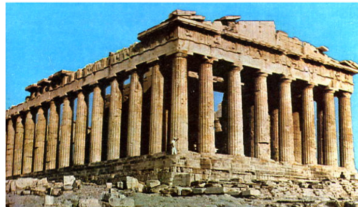
Partenone, VI sec A.C. Sistema trilitico
